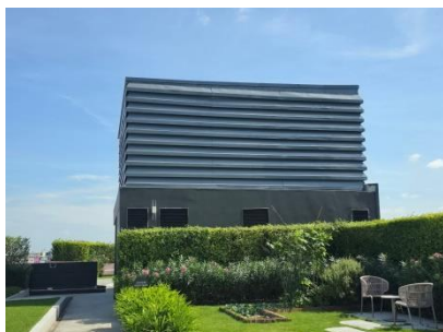
ถังสำรองน้ำดับเพลิงชั้นดาดฟ้า อาคาร A
